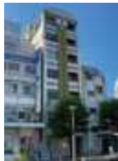
呉服町プラザビル
